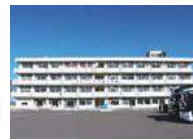
震災遺構 仙台市立荒浜小学校
